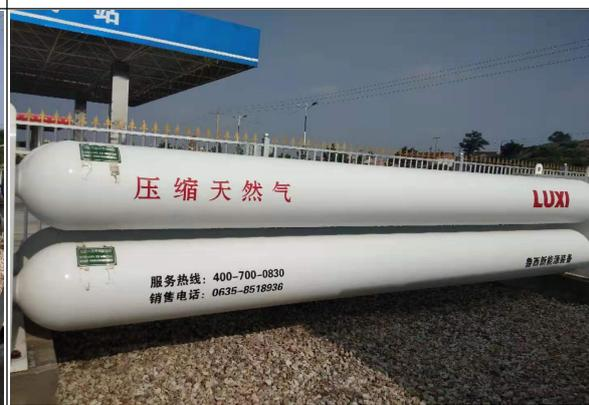
图 4 12m<sup>3</sup>CNG 储气瓶组
