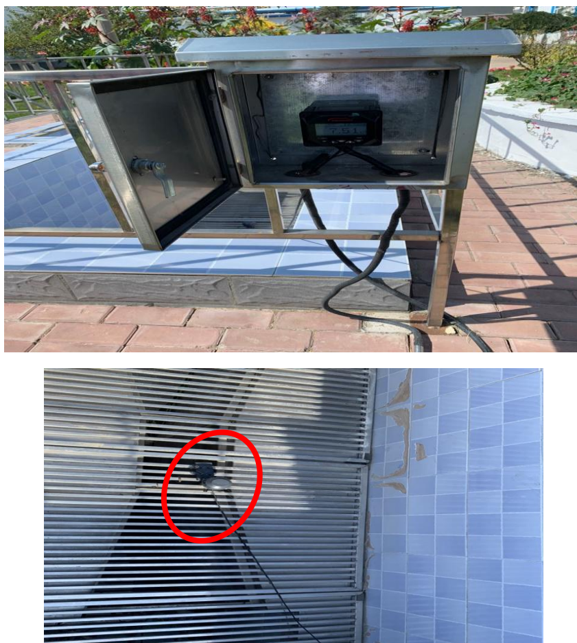
图1 排水口PH计探头安装位置
